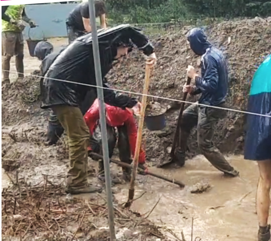
Des bénévoles des Chantiers Écologiques Massifs de 2022 qui ont payé pour se retrouver les pieds dans l'eau à creuser un trou (extrait d'une vidéo d'Hervé Jonas publiée sur Vimeo)
